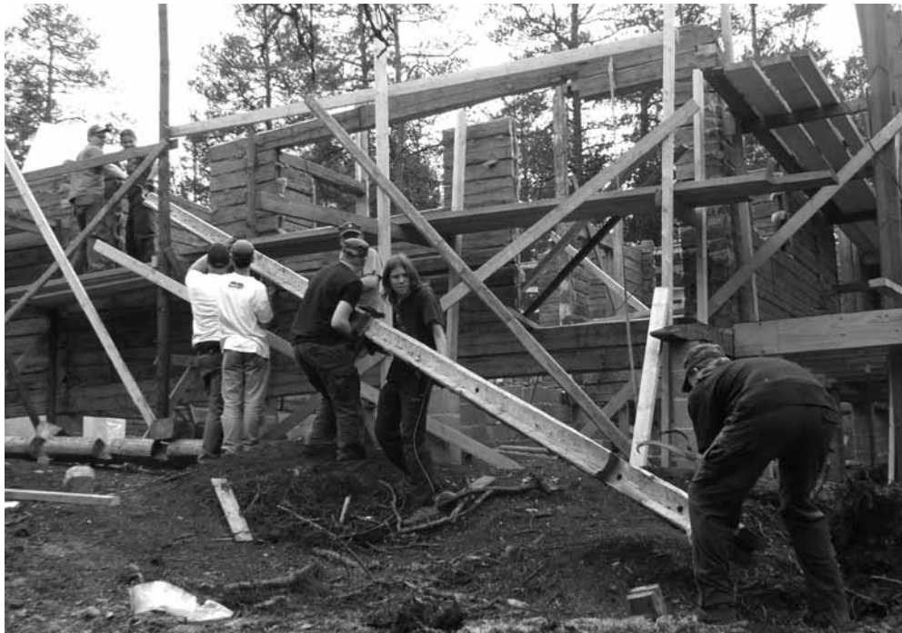
Kuva: Simo Laukkanen. Toisen sivun kuva: K.S.
