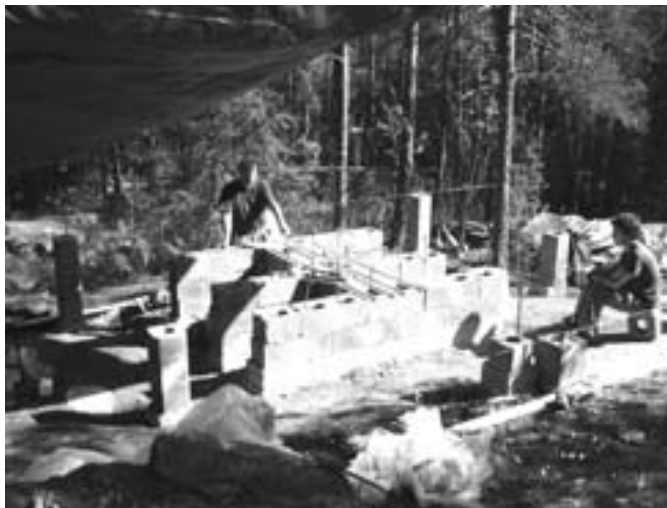
Saunan perustukset on jo valettu
